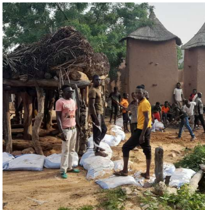
Dammetjes van zandzakken om het water tegen te houden
