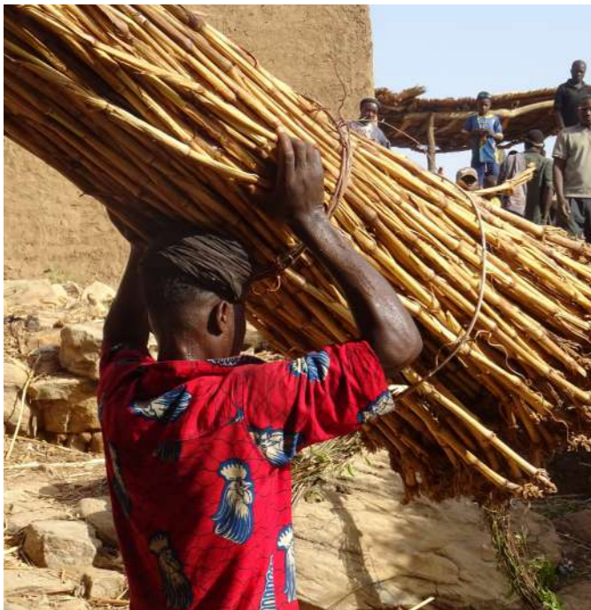
Iedereen helpt mee aan de bouw
