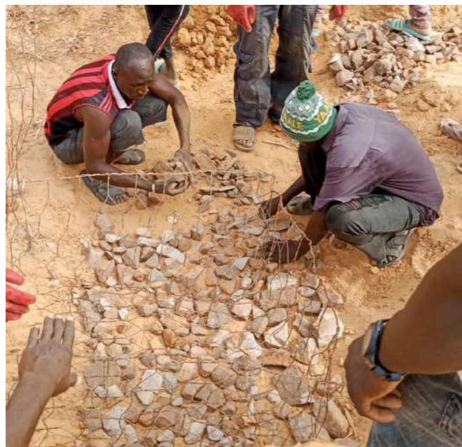
De aanleg van schanskorven
