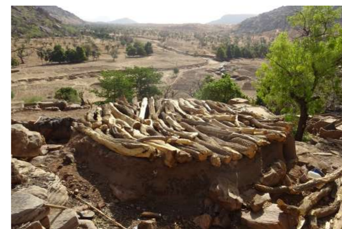
De wederopbouw van de toguna: een houten basis voor het rieten dak
