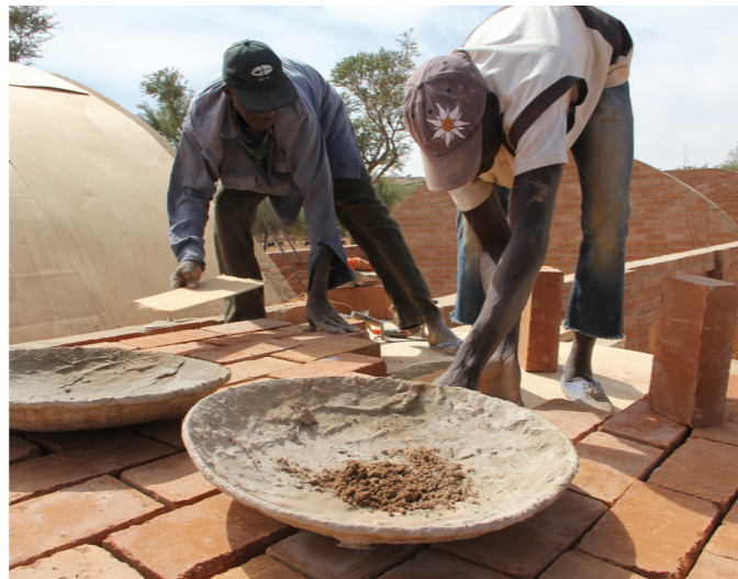
Constructie van tonggewelven in Tanouan Ibi
