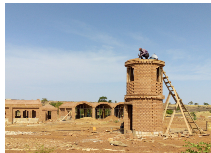
Constructie van de watertoren op de Praktijklyceum
