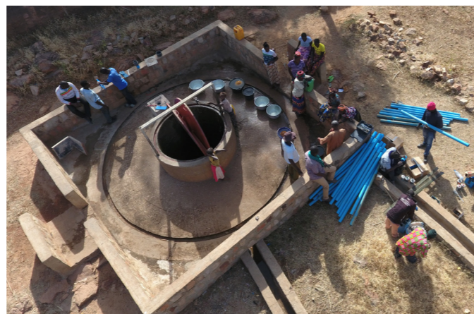
Installatie van de pomp
