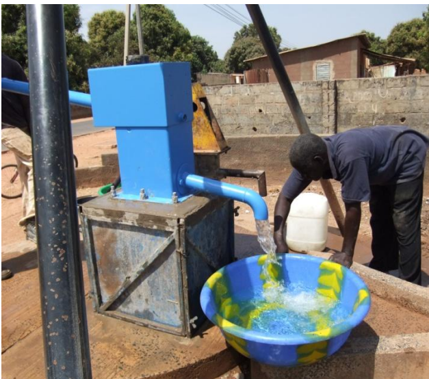
Finissez la plate-forme en béton solide
