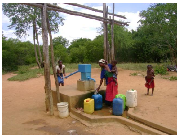
BluePump installée à 60 mètres au Mozambique.
