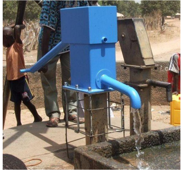
Renforcer la base au moyen des barres additionnelles en fer
