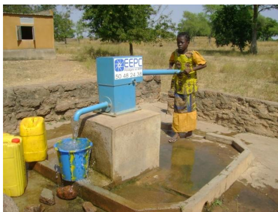
BluePump sur un forage réhabilité au Burkina Faso.
