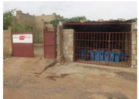
Het opslag van de pompen
