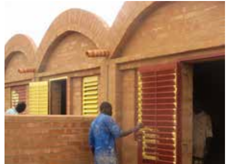
Het schilderen van de raam en deurkozijnen
