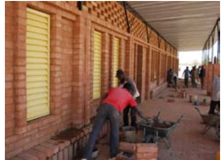
Werken aan de banken en vloer in Sono Ma
