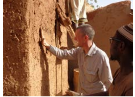
Les over modder voorbereiding
