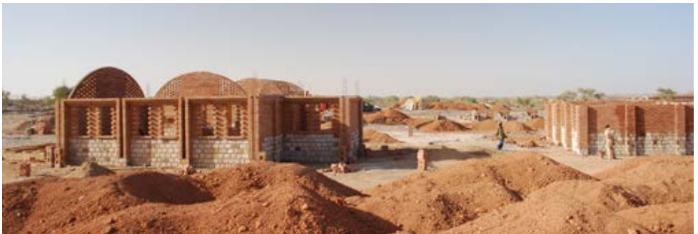
Zicht op de bouwplaats
