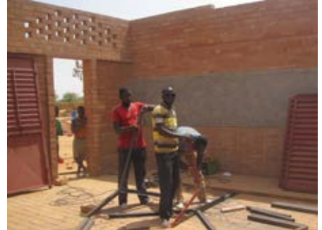
Staalwerk op de bouwlocatie in Ogodengou
