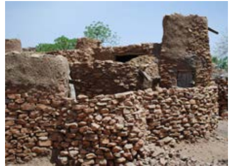
Volgende restauratie van een huis in Nando
