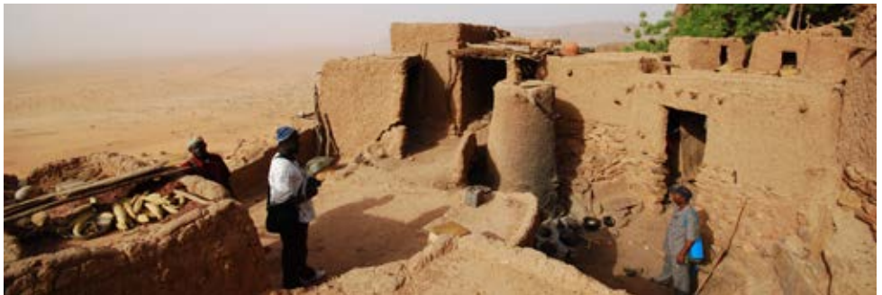
Het volgende restauratie project met betrekking tot vier huizen
