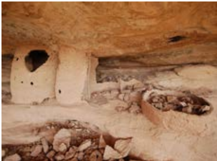
Leem schade, vervuiling
