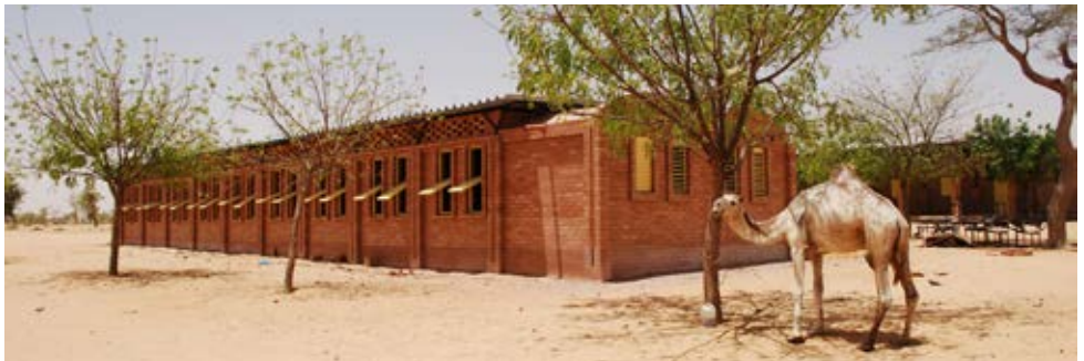
De school in Sono Ma
