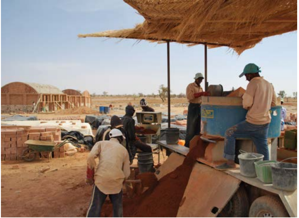
Productie van leemstenen op de bouwlocatie
