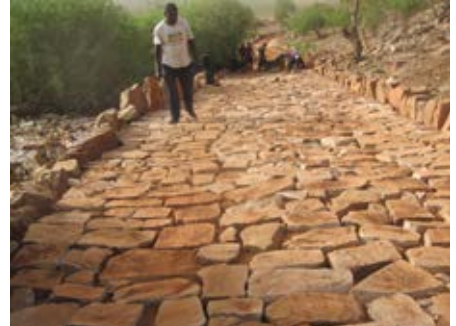
Reparatie van de weg naar Nando
