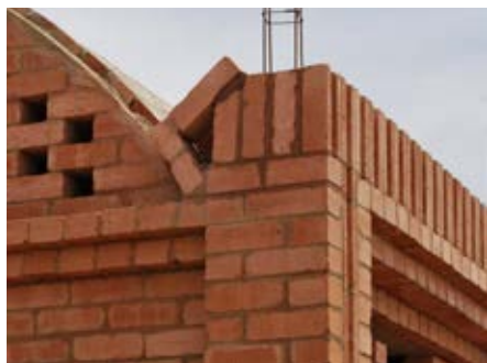
Detail van de dak rand
