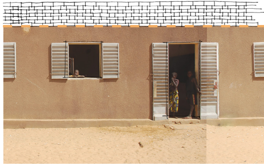
1. démolir le mur en suivant la ligne des grilles de ventilation
